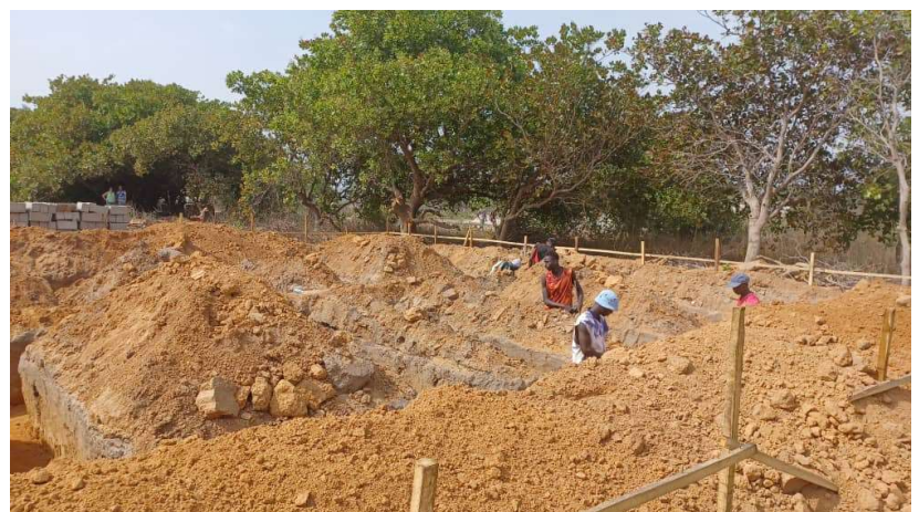
De lijnen voor de fundering worden uitgezet door dominee Senghore, die een eigen bouwbedrijf heeft
